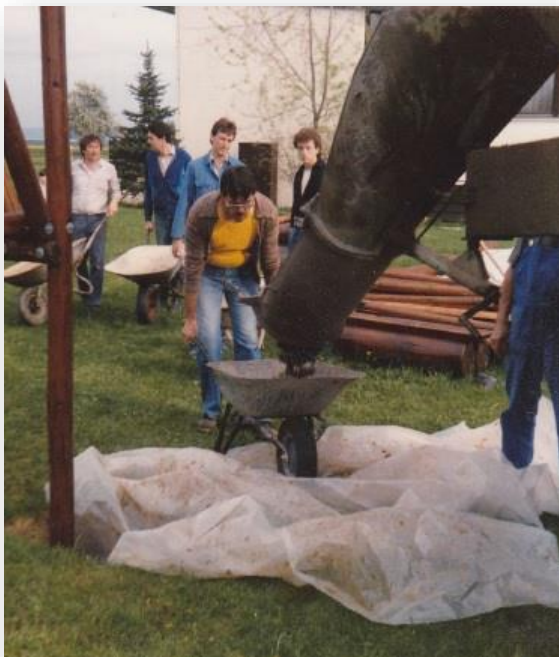
Das Spielgerüst kurz vor der Fertigstellung
